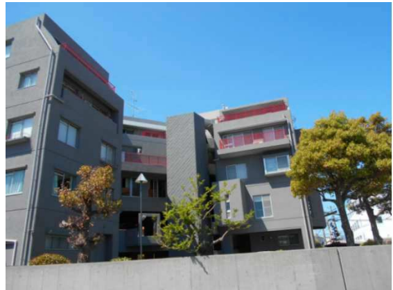
2019年 第三回大規模修繕 竣工時 エレベーター設置（2012年）
