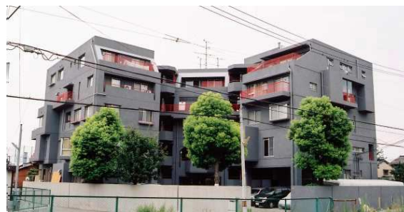
2004年第二回大規模修繕 竣工時（E L Vなし）
