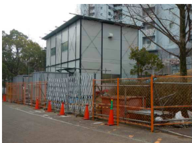
現場事務所（1階を事務所、2階を作業員詰所とした例）
