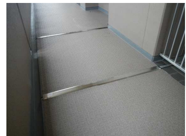
改修後の床と排水レール
