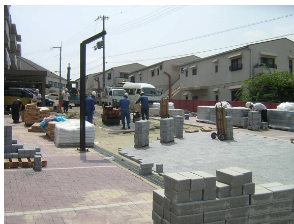
右手の車路にインターロッキングを敷設中、左手が駐車区画
