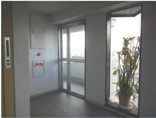
改修前のエレベーターホール
