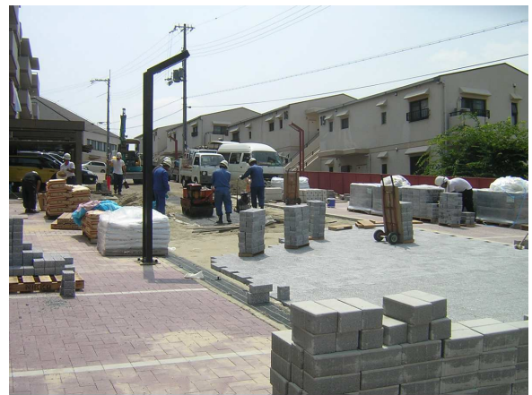
右手の車路にインターロッキングを敷設中、左手が駐車区画
