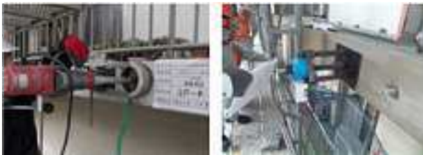
コンクリート強度測定
