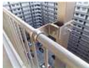
廊下手摺り補強金物
