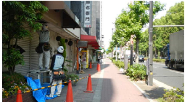
早朝からのシャッター工事
