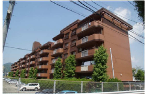
Cマンション外観。別報告では一部棟に傾斜があるとのことだが、一見、建物に大きな被害は見られない。(奥の棟の搭屋状は高架水槽部)
