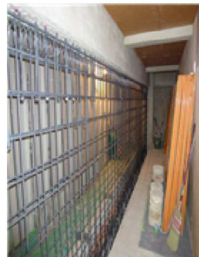
既存ブロック壁を撤去し耐震補強壁工事
