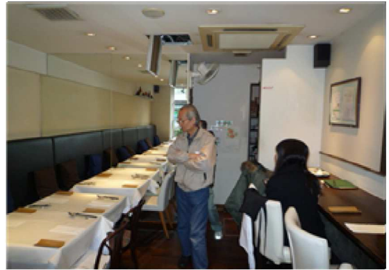
店の定休日に天井裏の調査を実施
