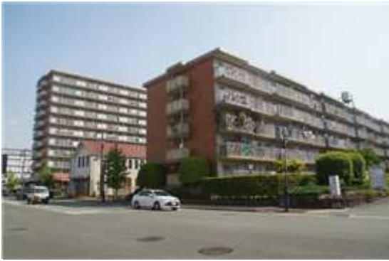
Bマンション(左)及びAマンション(右)の外観
