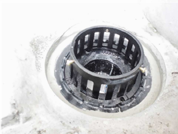
新しい排水金物の設置完了
