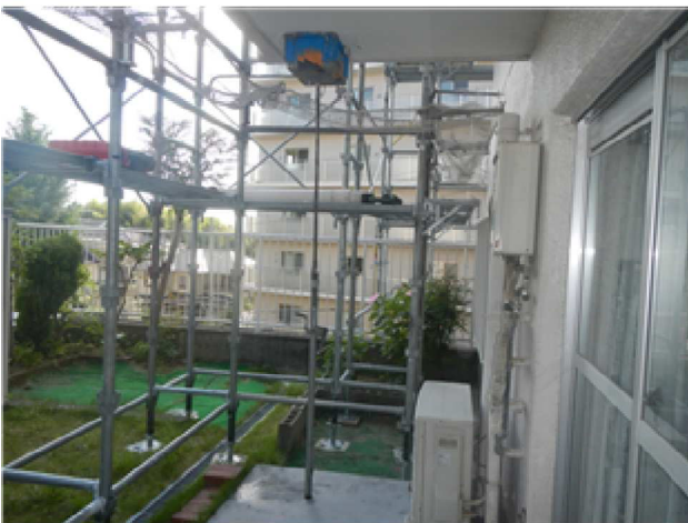
ダイヤモンドカッターの排水をバケットで受ける
