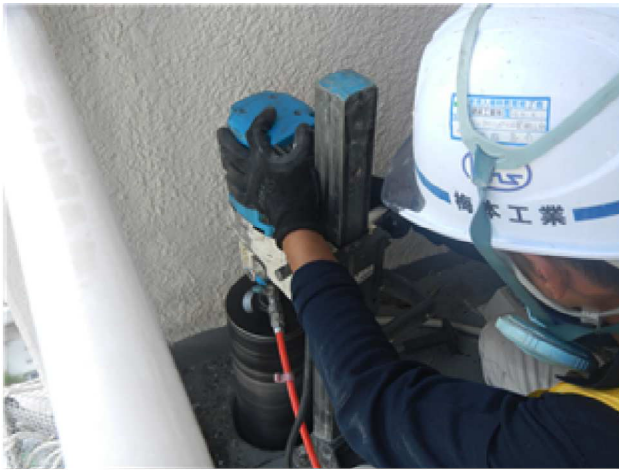
ダイヤモンドカッターを使用し排水金物を撤去
