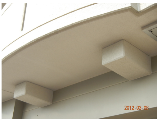
バルコニーの床を補強し安全確保
