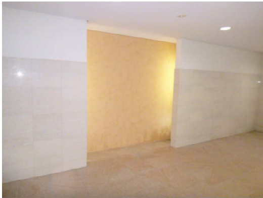
経年による退色・汚染がみられるニッチ
