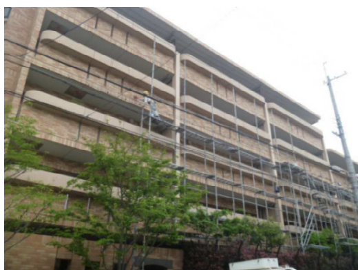
二丁掛けタイル貼りの外壁
