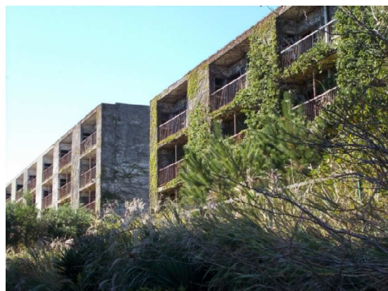
池島炭鉱社宅～廃墟となり蒿に覆われている
