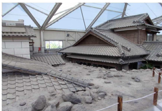
被災建物保存館～土石流によって1階が埋まった家屋
