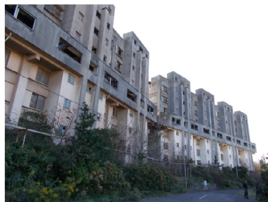
同上8階建集合住宅～横につながっているのが5階廊下
