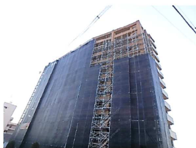
仮設足場設置中の様子
