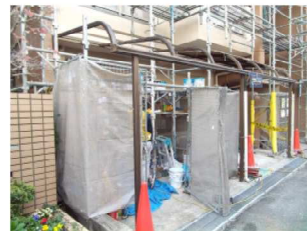
自転車置場を利用した作業員詰所・資材倉庫
