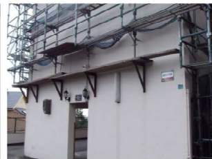
敷地内車路確保のための鋼材を使った持ち出し足場
