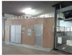
屋内駐車場の空きスペースを利用した現場事務所
