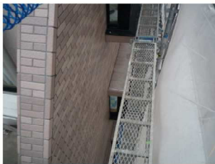
隣地境界線までの僅かな空地に設置した単管足場
