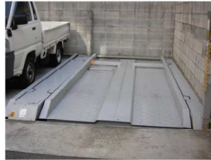
利用の少ない倉庫を管理員さんのトイレに（改修後）
