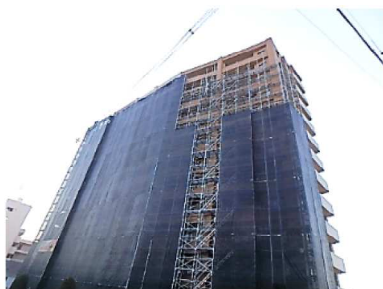
仮設足場設置中の様子
