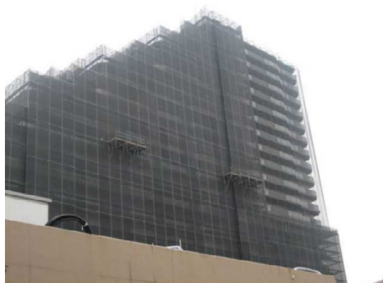
枠組み足場(左) ゴンドラ足場(右上)
