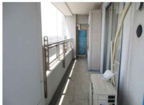
明るいバルコニーでの作業状況
