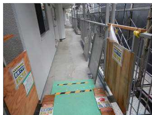
工事中の安全対策
