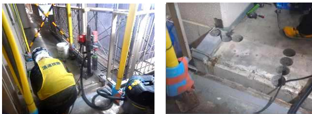
コア抜き工事
