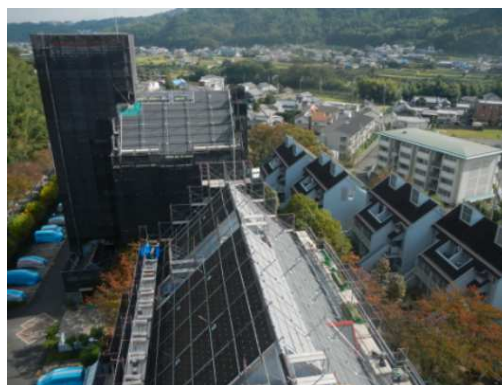
形状の異なる住棟にかかる足場
