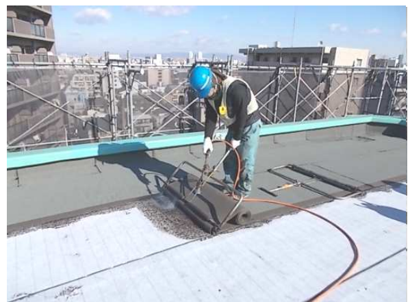
屋上防水全面改修工事（かぶせ工法）
