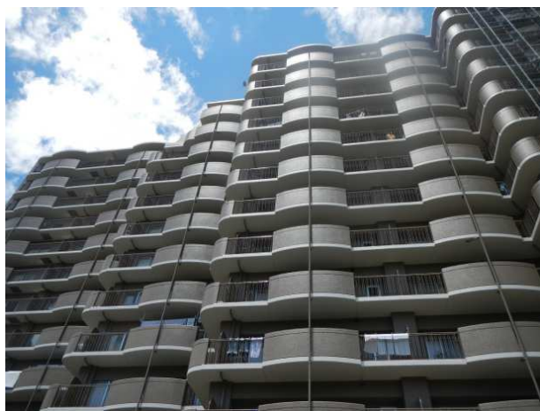
増設された樋が連続するマンションの景観
