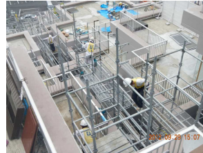
屋外階段の上部に足場架設
