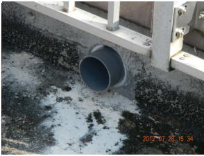
オーバーフロー管の排水能力を上げるために大きなサイズに交換
