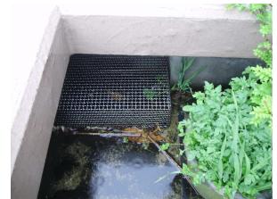
排水口に枯葉が詰まらないように金網を製作して防ぐ
