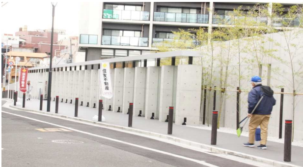
天王寺駅近くのマンションの道路との境界塀 (コンクリートの手前に竹、壁の隙間は透明ガラスとなっています)
