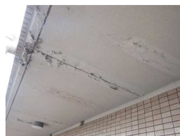
写真2 廊下の天井塗装
