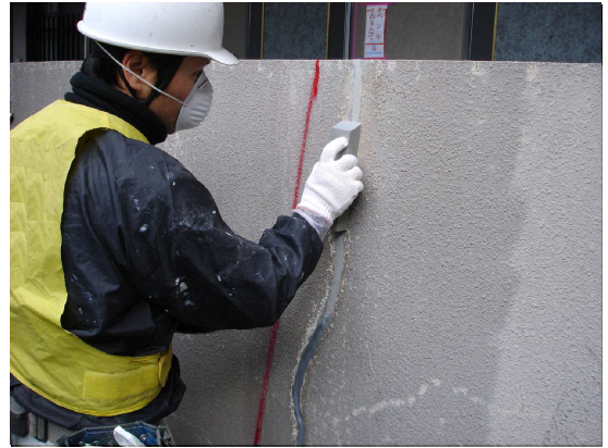
ひび割れの補修
