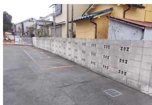
隣地境界の C B 塀（改修前）
