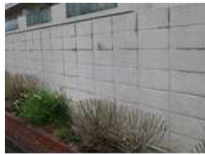
北側のCB塀（改修前）
