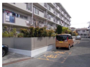
専用庭周囲のアルミフェンス（改修後）
