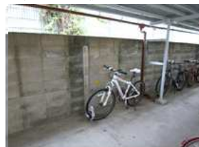
駐輪場の C B 塀（改修前）
