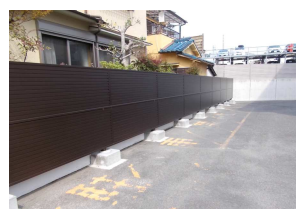
隣地境界のアルミフェンス（改修後）
