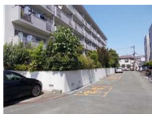
専用庭周囲の C B 塀（改修前）
