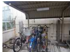
駐輪場に新設した控壁
