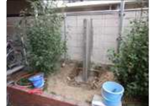
新設した控壁
