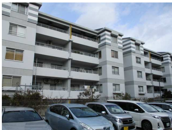
外壁塗装工事完了
