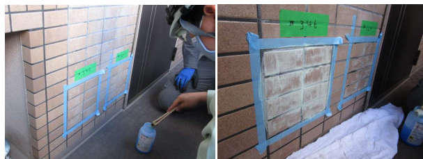
テスト施工の状況
