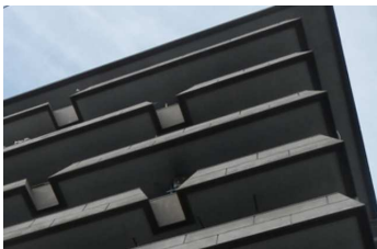
斜面状のバルコニー手摺壁
