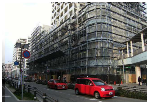
夜間の足場組立工事を終えた、早朝のマンション
