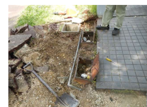
水道管を修理
