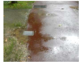
雨水桝を増設
