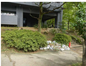
土砂流出を防ぐ土嚢
