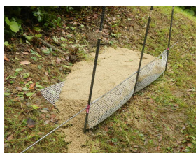
鉄筋杭とネット張り 砂利敷き込み
