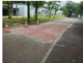
インターロッキング 沈下部の貼替
