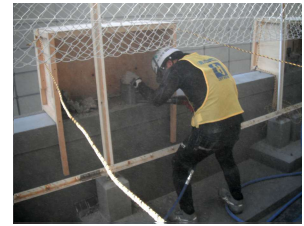
木製の箱の中で手すりを安全に撤去
