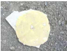
剥離したタイルの裏面 円形が注入された樹脂
