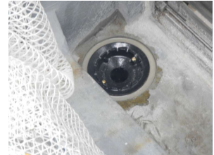
口径の大きな排水金物を設ける
