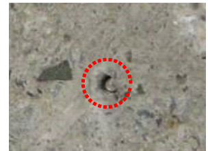
埋没したステンレスピン
