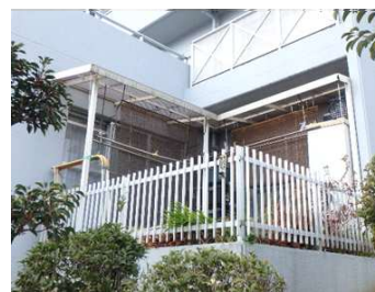
専用庭一面に設けられた庇
