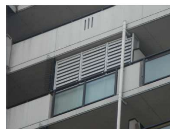
バルコニーを塞ぐ鋼製スクリーン
