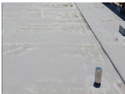
押えコンクリートと露出防備の取合部分
